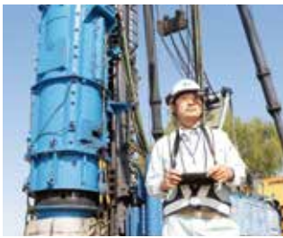
各工事段階での施工状況確認
