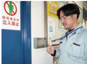
情報漏洩を防ぐため、ICカードで入退室管理
