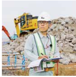
工事現場の状況を照合する
