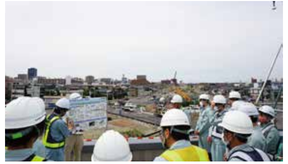
現場見学 (R49 粟ノ木バイパス)
